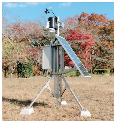
気象状態と放射線量を同時に計測し遠隔監視するシステムの改良 (架台改良、独立電源付加、データ処理装置改良等)
